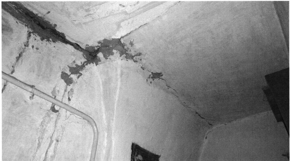
Рис. 10. Множественные трещины на потолке и перегородках второго этажа.
