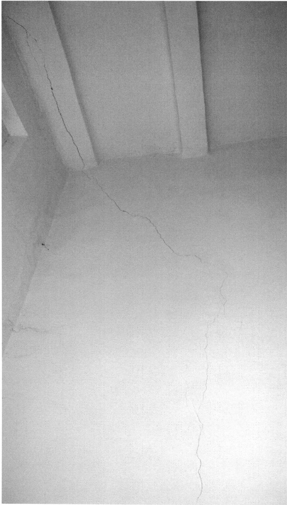
Рис. 17. Трещина в кирпичной кладке лестничной клетки высотой в два этажа. Берёт начало в месте прохождения газовой трубы через стены и заканчивается в надоконной зоне, ширина раскрытия 1...2 мм.
