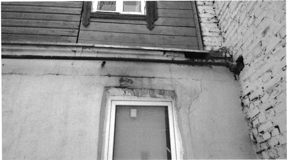
Рис. 5. Трещины в кирпичных стенах первого этажа здания.
