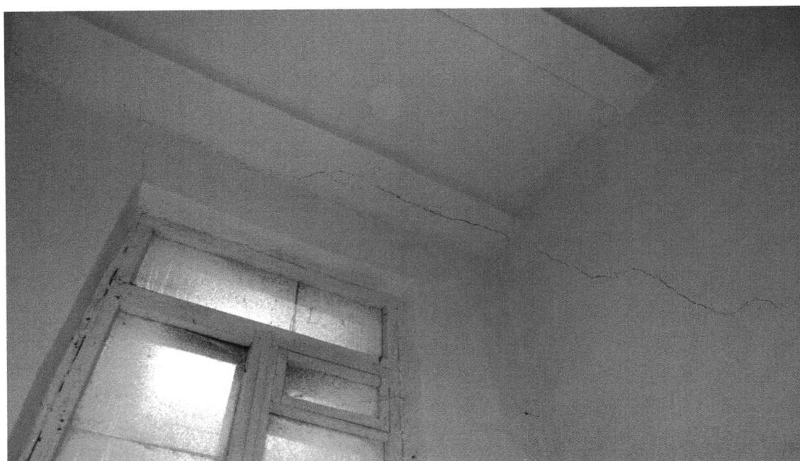
Рис. 16. Трещина в кирпичной кладке лестничной клетки высотой в два этажа. Берёт начало в месте прохождения газовой трубы через стены и заканчивается в надоконной зоне, ширина раскрытия 1...2 мм.
