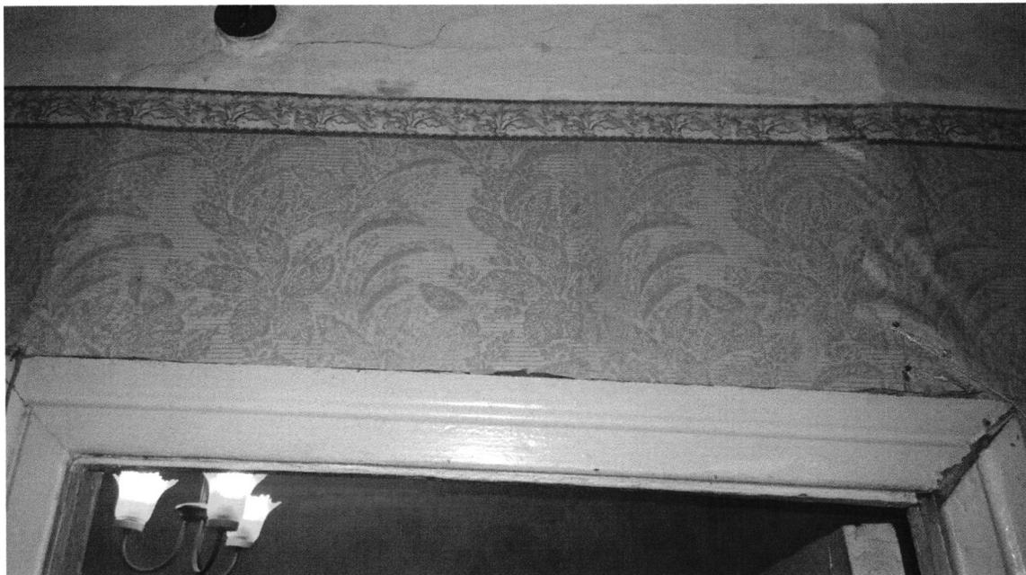
Рис. 8. Множественные трещины на потолке и перегородках второго этажа. Перекошенные дверные коробки – свидетельство деформаций остова здания.
