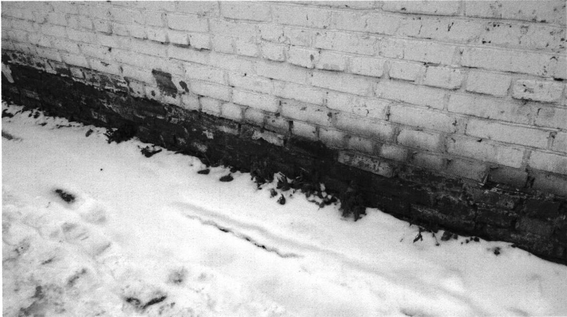
Рис. 2. Фасад жилого дома со двора. Плесень на кирпичные кладки цоколя здания как следствие капиллярного подсоса влаги.
