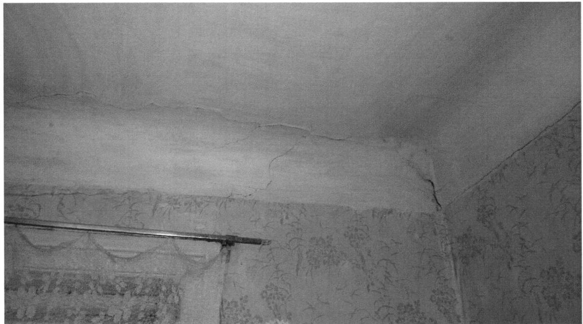
Рис. 6. Множественные трещины на потолке и перегородках второго этажа.
