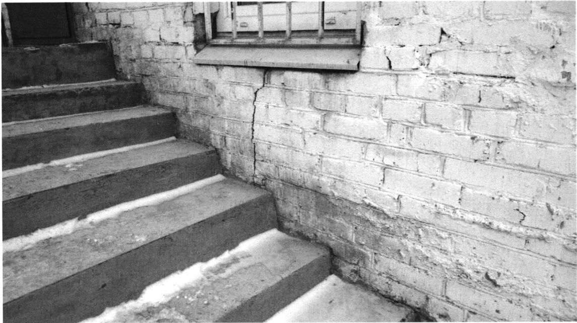
Рис. 3. Плесень на кирпичной кладке цоколя здания как следствие капиллярного подсоса влаги.
