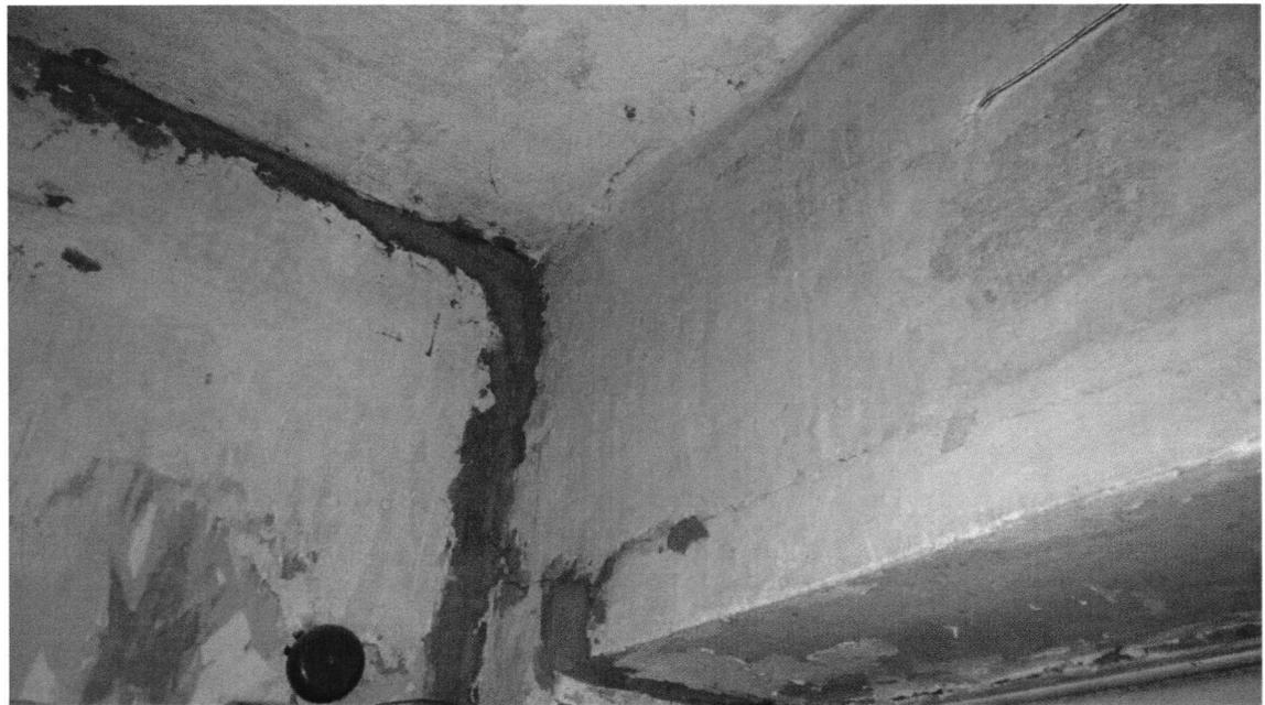
Рис. 11. Множественные трещины на потолке и перегородках второго этажа.
